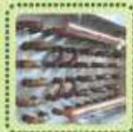
El aire caliente y los humos que salen de la máquina son absorbidos por la batería de intercambio con aletas y dan su calor al agua circulante en los serpentines.
